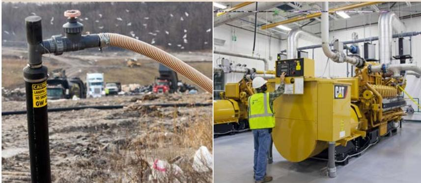
Un pozo recoge el metano que produce la basura en descomposición en un basural ubicado en Smith's Creek, Michigan (izquierda). Los motores generan electricidad a partir del metano (derecha).
