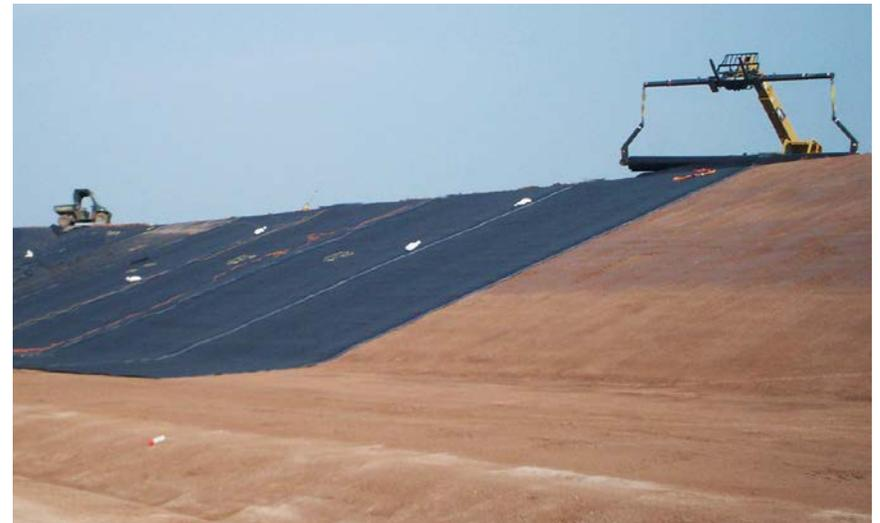
Unas máquinas despliegan un revestimiento para construir un nuevo basural.
